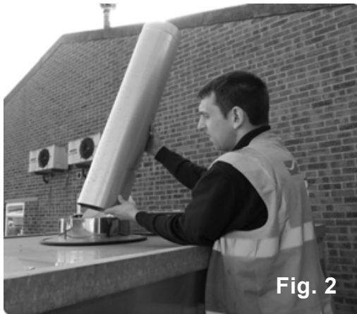
Fig. 2 Enlever le couvercle de protection et ajuster la cheminée (1 mètre).
